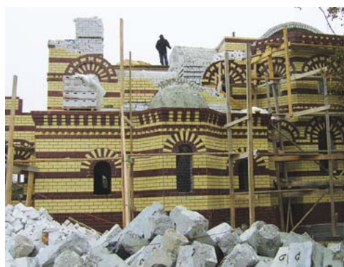
Строительство Покровской церкви. 2009 г.
